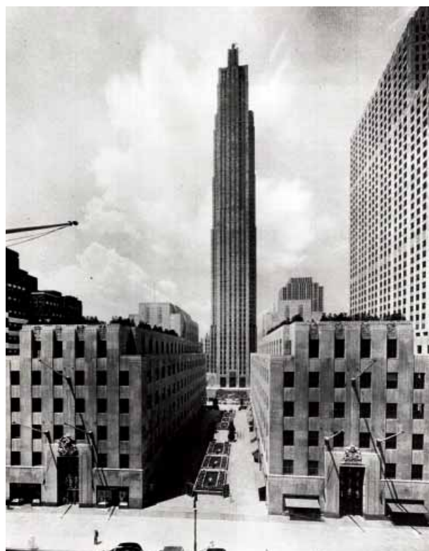
Рис. 2. Здание Джeneral Электрик Билдинг (General Electric Building) и сады на крышах зданий Британии и Франции. 1935 г. [2]
