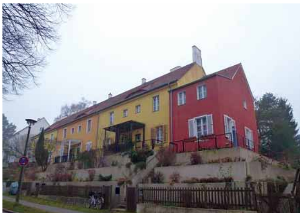
Рис. 13. Пос. Фалькенберг. Группа домов, окрашенных в теплые тона [14]
