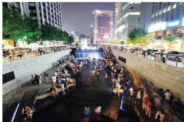
Рис. 5. Канал Чон-Га (г. Сеул, Южная Корея) [9] Fig. 5. Chon-Ga Channel (Seoul, South Korea) [9]
