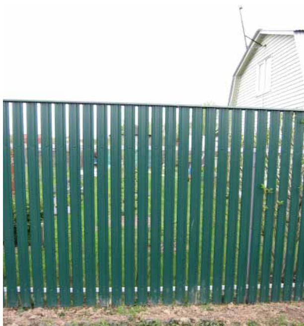
Рис. 9. Ограждение из металлического штакетника. Сохраняется единство пространства участка и линии Fig. 9. Metal fence. The unity of the space of the site and the line is preserved
