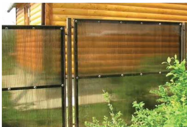
Рис. 10. Ограждение из поликарбоната. Сохраняется единство пространства участка и линии [13] Fig. 10. Fencing made of polycarbonate. The unity of the space of the site and the line is preserved [13]
