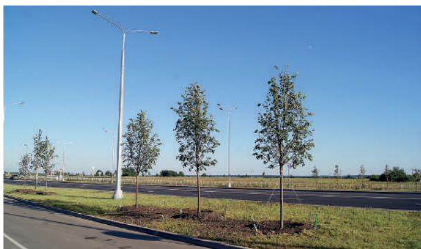
Рис. 13. Элементы наружного освещения автомобильной дороги Fig. 13. Elements of exterior lighting of a motorway
