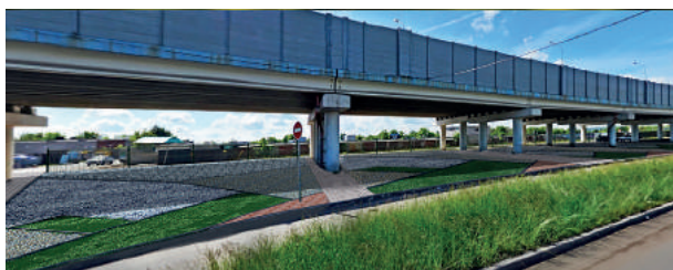
Рис. 12. Декорирование подэстакадного пространства с применением покрытий разного типа (асфальт, искусственный газон, резиновое покрытие) Fig. 12. Decoration of the under-flyover space with the use of different types of coatings (asphalt, artificial turf, rubber coating)
