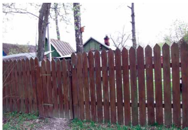
Рис. 1. Ограждение из деревянного штакетника. Сохраняется единство пространства участка и линии
