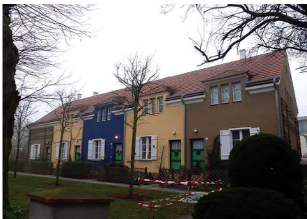
Рис. 14. Пос. Фалькенберг. Членение фасада теплыми и холодными цветами [14]
