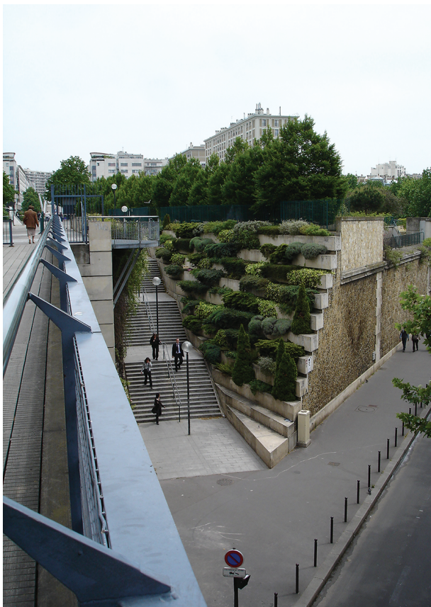
Рис. 5. Лестница на променад Fig. 5. Stairs at the promenade
