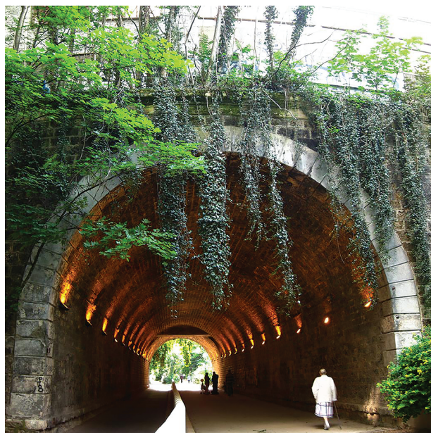
Рис. 7. Тоннель Fig. 7. Tunnel
