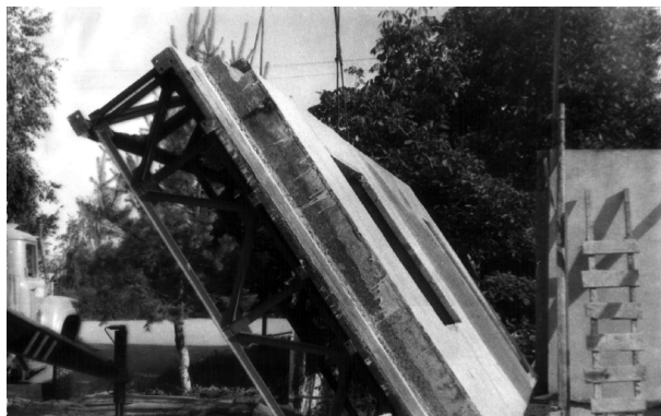
Рис. 4. Подъем трехслойной стеновой конструкции с помощью автокрана
