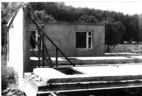
Рис. 5. Установка трехслойных стеновых конструкций
