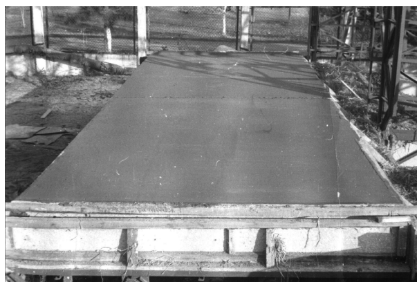
Рис. 3. Выдержка конструкции до набора бетоном монтажной прочности Fig. 3. Exposure of the structure to concrete set-up
