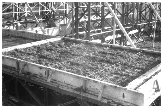
Рис. 2. Древесно-цементная смесь, уложенная в опалубку Fig. 2. Wood-cement mixture laid in formwork
