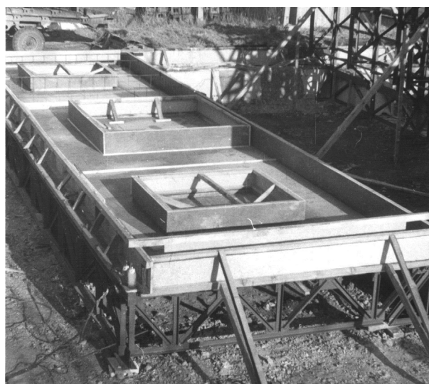
Рис. 1. Опалубка стеновой панели с установленными бортами и проеомообразователями
