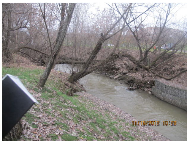
Рис. 3. Река Сетунь в низовьях. Оползневые процессы резко активизируются на вытоптаных берегах, где набережные не укреплены
