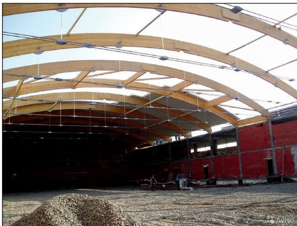
Рис. 3. Арочные большепролетные клееные деревянные конструкции
