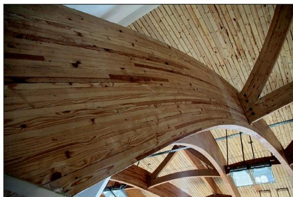
Рис. 1. Большепролетные клееные деревянные конструкции
