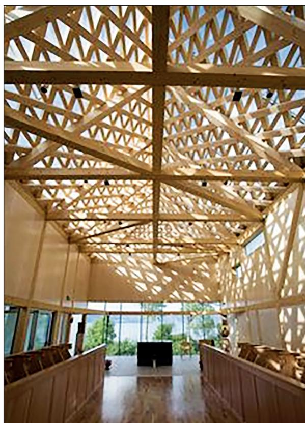
Рис. 2. Балочные большепролетные клееные деревянные конструкции
