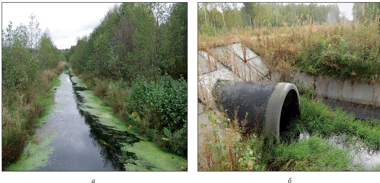
**Рис. 5.** Мелиоративный канал в лесном фонде при отсутствии технических уходов: *а* — заросший мелиоративный канал; *б* — заиленный откос
