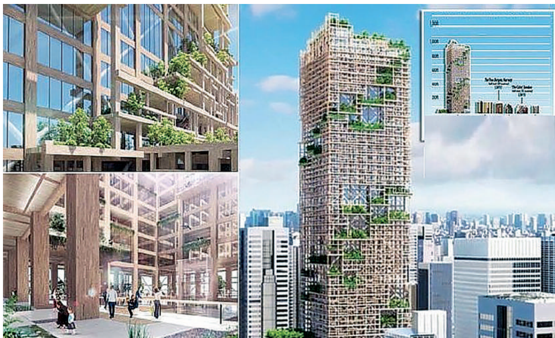
Рис. 3. Проект деревянного небоскреба в центре г. Токио высотой 350 м Fig. 3. The project of a wooden skyscraper in the center of Tokyo with a height of 350 meters
