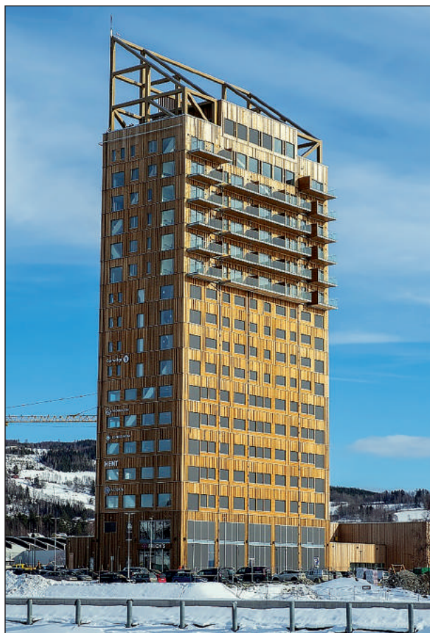
Рис. 5. Конструкция деревянной башни «Мьёс» в Норвегии высотой 85,4 м Fig. 5. The construction of the wooden skyscraper Mies in Norway is 85.4 meters high
