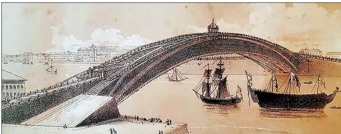
Рис. 1. Проект деревянного одноарочного моста И.П. Кулибина через р. Неву пролетом около 300 м
