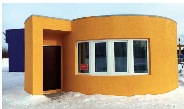
Рис. 3. Жилой дом, «напечатанный» в России, г. Ступино, компания Apis Cor Fig. 3. Residential building «printed» in Russia, Stupino, Apis Cor company
