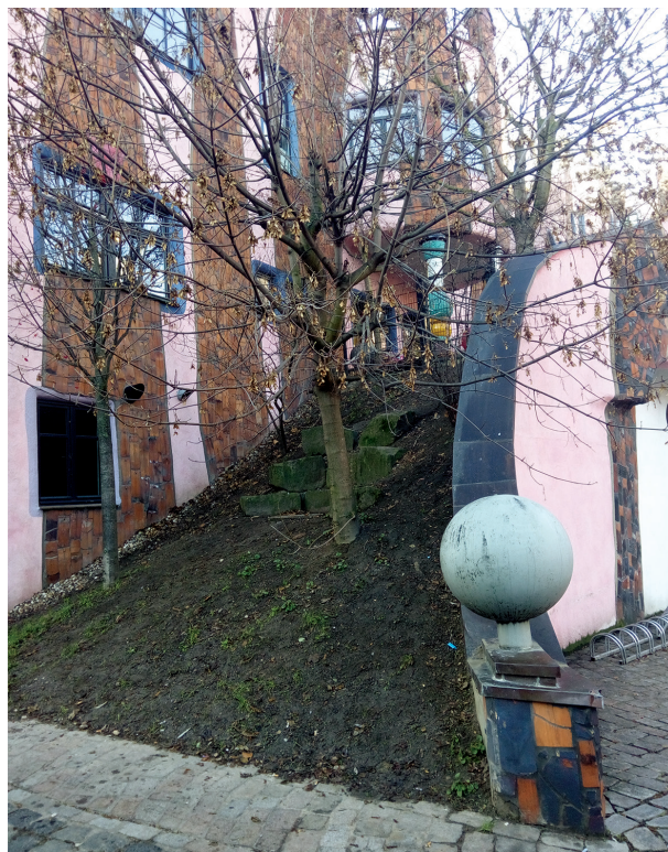
Рис. 6. Состояние деревьев и травянистого покрытия на наклонном участке кровли при входе в здание Зеленой цитадели
