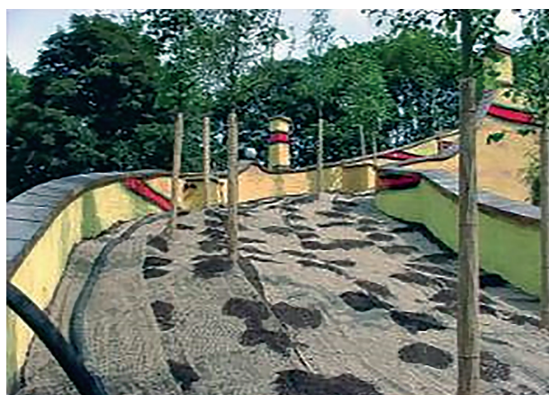
Рис. 7. Дом Рональда Макдональда. Детали устройства конструкции зеленой крыши: а — посадочный ком саженца с ремнями для дальнейшей фиксации; б — участок кровли с уклоном от 20° — 30° усилен растровыми решетками; в — стабилизирующее джутовое покрытие в верхнем слое покрытия [23]
