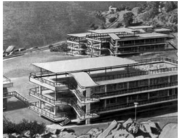
Рис. 7. Перечисленные унифицированные железобетонные детали и построенные корпуса из них: 1 — полурама каркаса зданий; 2 — настил перекрытия; 3 — лестничный марш с консольными площадками; 4 — Т-образная консольная опора лестничных маршей; 5 — стойки грибовидного перекрытия; 6 — треугольный элемент грибовидного перекрытия; 7, 8 — фундаментные блоки
